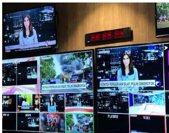
Gambar 4. 9 Control Room di Studio 5 Sumber : Dokumentasi Pribadi
